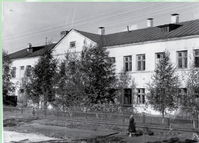
Здание роддома № 1 1939 года постройки
